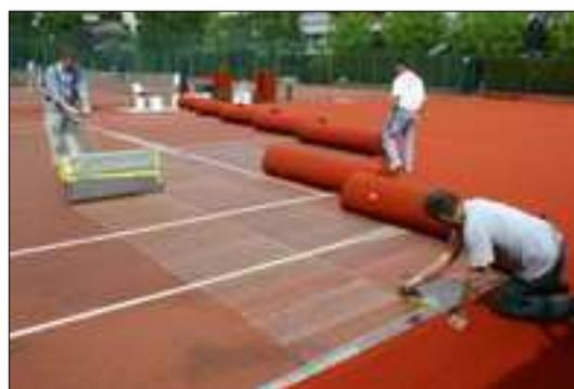
Su base impermeabile la membrana viene totalmente incollata, mentre su base permeabile il collante va applicato in strisce per evitare di intasarla pregiudicane la permeabilità.
